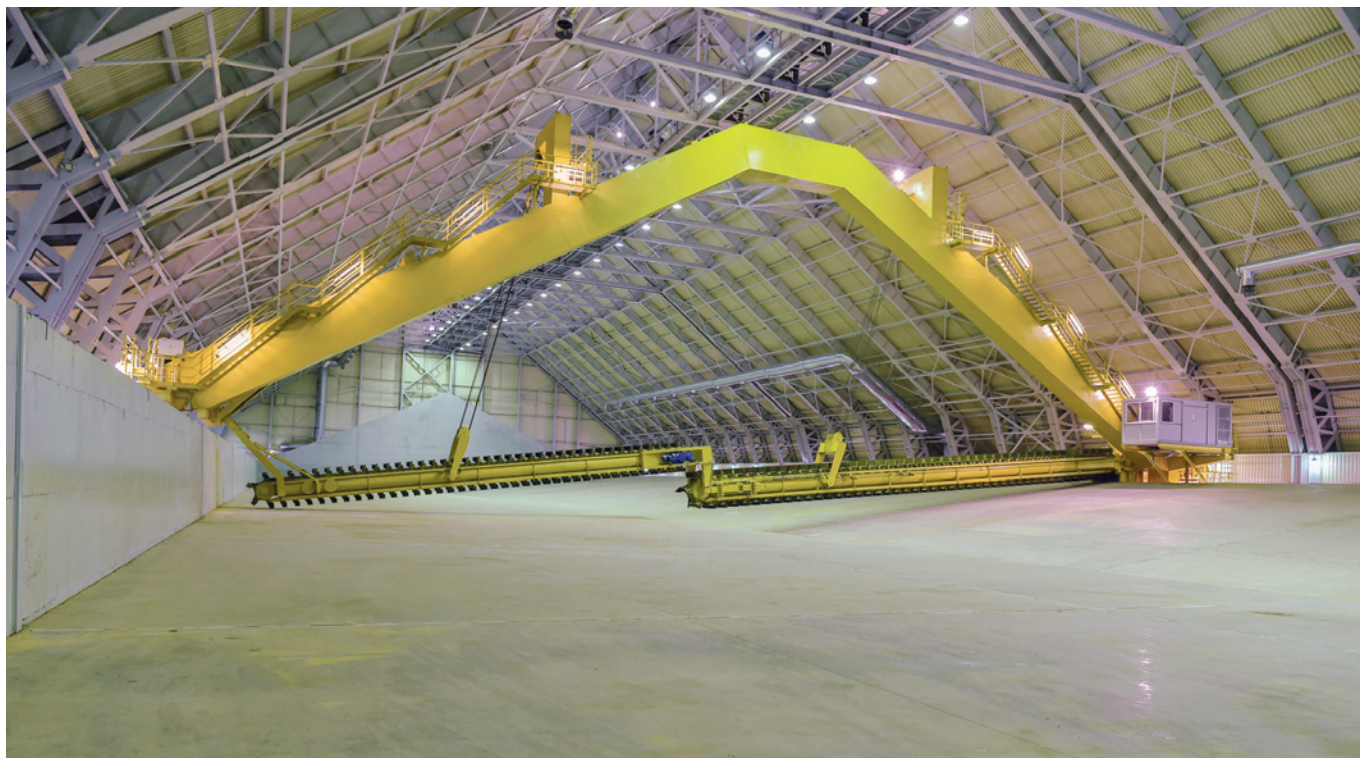
Склад карбамида насыпью в ОАО «Аммоний»
